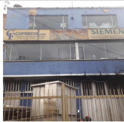
FOTO 2. PREDIO DONDE REPOSA LA RAMA DE TERMOFIJADO OBJETO DE MEDIDA PREVENTIVA
